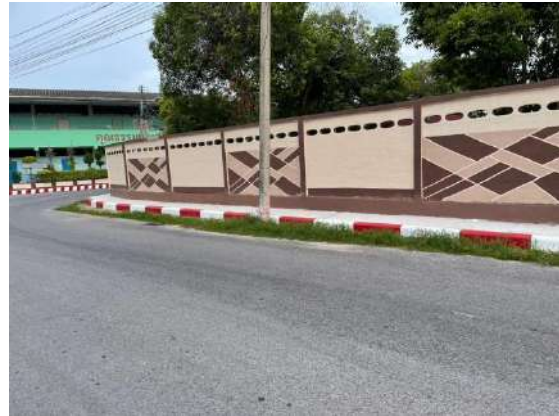
ทางเดินปลอดภัยบริเวณริมรั้วโรงเรียน
